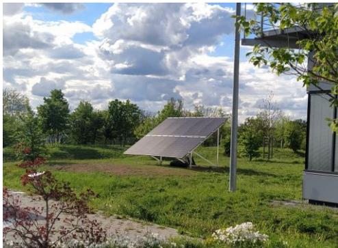
Abb. 2: PVT-Kollektoren als Wärme-, Kälte- und Stromquelle für das RENBuild-System, hier auf dem Freiflächenversuchsgelände des CAE als Teil der Versuchsanlage. Sie fungieren als absolut lautlose Außeneinheit der Wärmepumpe und können sowohl auf dem Dach als auch in der Fassade eingesetzt werden. Foto: @CAE
