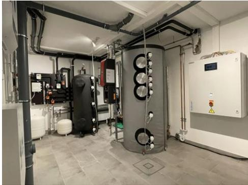
Abb. 1: Technikzentrale des RENBuild-Systems im Demowohngebäude des Projektpartners Hanse Haus mit Hochleistungshybridspeichern, optimierter Wärmepumpe und intelligenter Gebäudeautomation. Foto: @Hanse Haus
